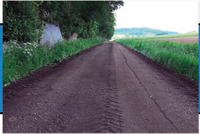
Final nach SGRF und Verdichtung
