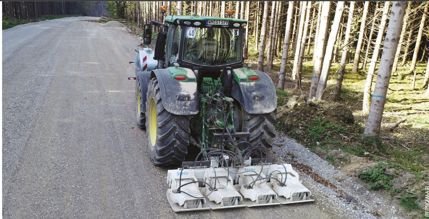
Viermal 80 kN Wuchtkraft wirken, wenn der Stehr SBV 80 H4 seine 3 m breiten Bahnen zieht. Die Wirkung ist enorm: Ein Übergang reicht für die geforderte Verdichtungsleistung. Das beschleunigt die Abläufe, spart Sprit und somit doppelt Geld. Das Trägergerät ist ein John Deere 6250 R mit stufenlosem Fahrtrieb.
