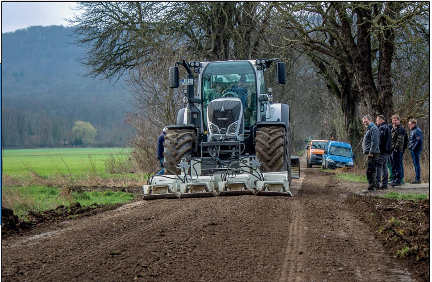
Durch das schnellere Profilieren kann zeitnaher mit dem an der Front des Traktors angebrachten **Stehr**-Plattenverdichter SBV 80 H4 oder H3 verdichtet werden. Somit werden in Zukunft mit dieser Kombination Unterhaltung und Pflege von Schotterstraßen enorm günstiger und viel schneller durchgeführt.
