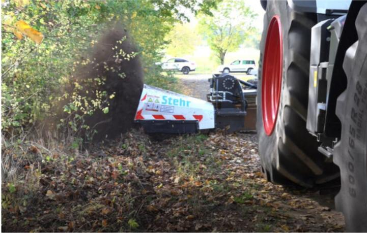
Die überwachsene Bankette wird abgefräst, damit das Wasser nachher seitlich abfließen kann.
