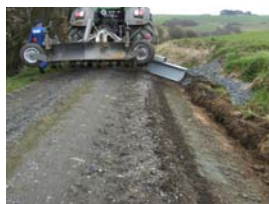
Abschieben des Banketts
