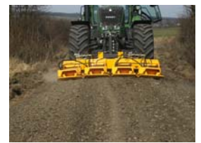
Neuprofilierung des Weges / Verdichtung
